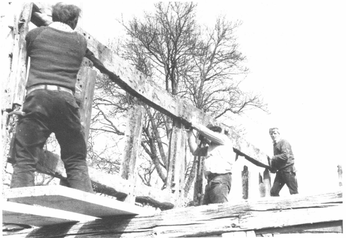
Zimmerleute bei der Demontage einer Fachwerkscheune
