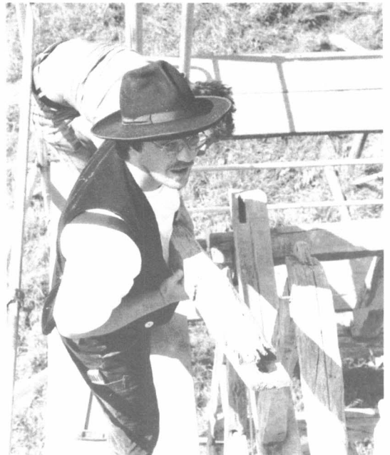
Burkhard Zinn bei der Demontage der Scheune Reinshagen
