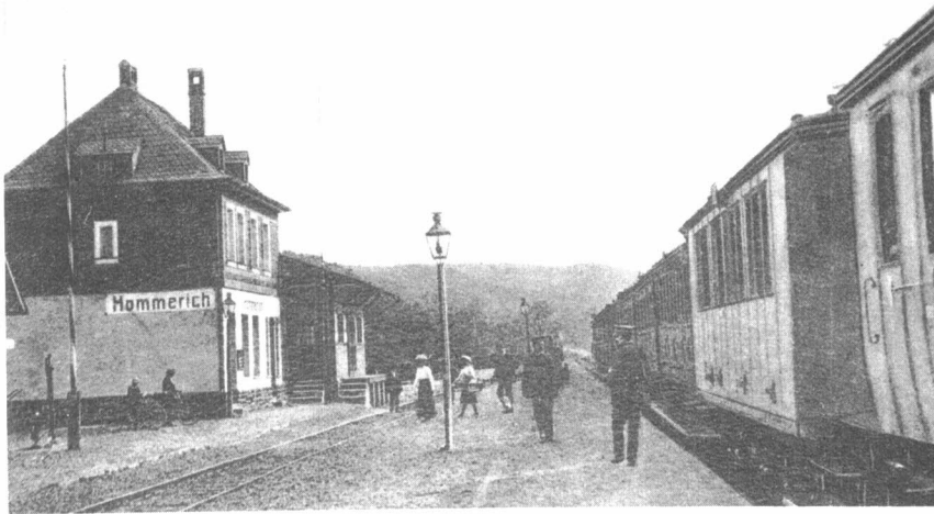
Abfertigung eines Personenzugs im Bahnhof Hommerich 1912
