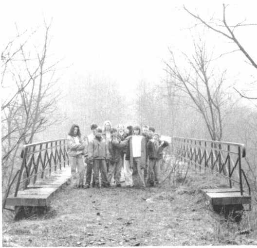
Weg über das große Viadukt bei Linde
