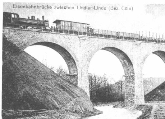
Das fertiggestellte Viadukt über das Sülztal (noch ohne Talstraße!)
