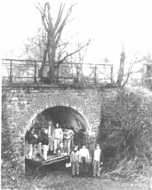
Eisenbahnbrücke bei Schwarzenbach
