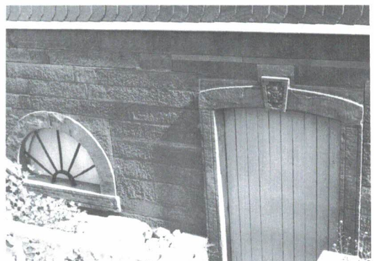
Abb. 9 Werksteinarbeiten am Kellersockel des Hauses Kelleter, die 1990 wieder freigelegt worden sind.
