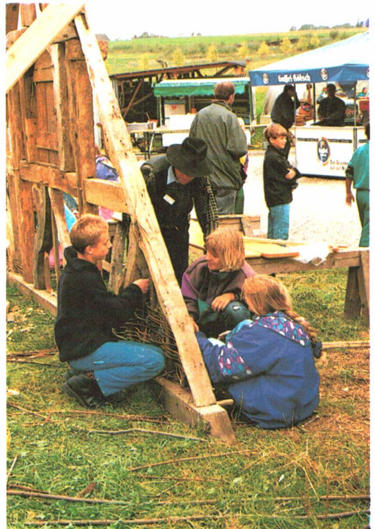
▲ Am Fachwerkgiebel lernten die Schüler, wie die Eichenholzstaken fachgerecht zugeschlagen werden
