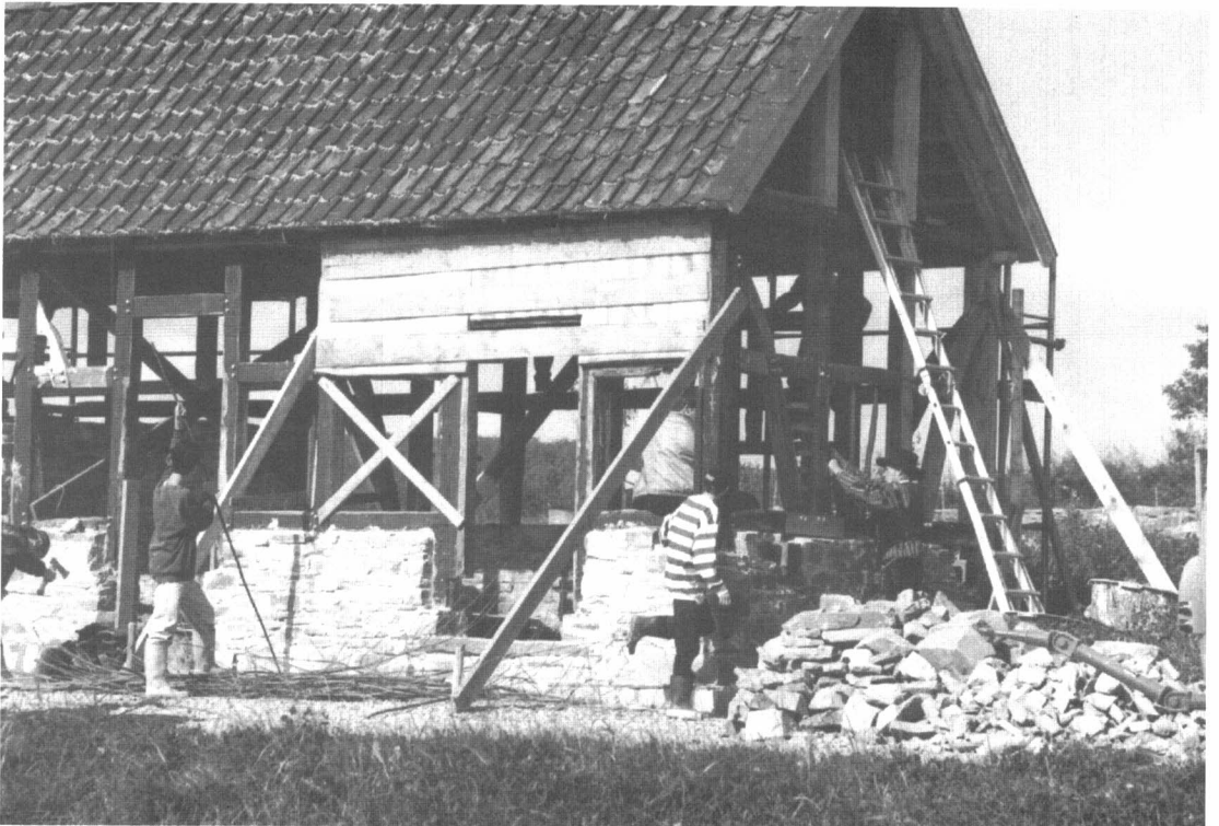
Wiederaufbau der Feilenhauerei Irlenbusch während der museumspädagogischen Woche
