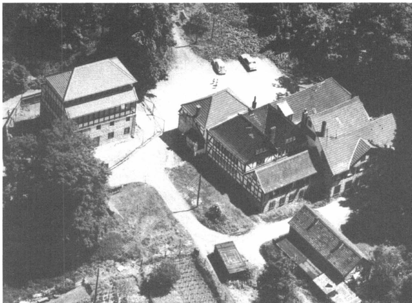
Die Papiermühle Alte Dombach von Nordwesten. Im größten Gebäude lagen die Produktionsräume und die Wohnungen der Besitzer. Der inzwischen zugeschüttete Mühlgraben verlief entlang der sichtbaren Fassade. Bei dem kleinen Gebäude rechts handelt es sich um einen Stall, bei dem großen Gebäude links um ein Trockenhaus. Foto: Rhein. Industriemuseum.
