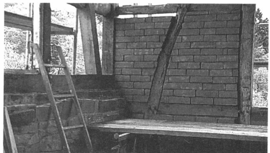
Lehmsteine frisch aus der Ziegelpresse . . . ... und als Ausfachungsmaterial in der Schmiede Anhalt
