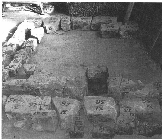
Ein Puzzle mit 500 Teilen: Die Schmiedesse beim Wiederaufbau
