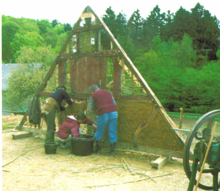
Am Giebel konnte historisches Lehmfachwerk mit Eichenstaken, Weidenruten und Strohlehm geübt werden.
