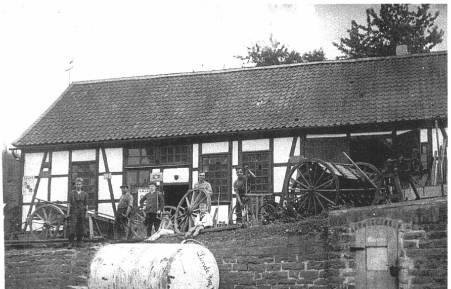
Ansicht von der Straße, rechts unten die Toiletten der benachbarten Kegelbahn.
