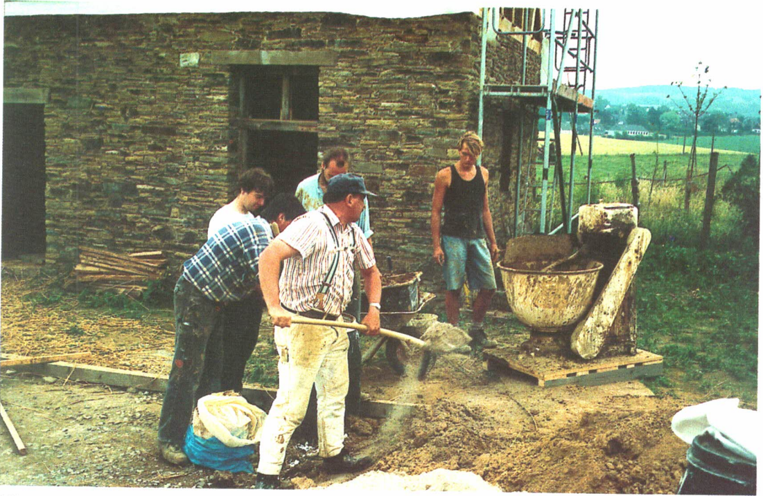
Nicht zu fett und nicht zu mager darf der Lehm sein. Bei der Aufbereitung hilft eine alte Brotknetmaschine. Maurer des Museums zeigen den Seminarteilnehmern das richtige Mischungsverhältnis.
