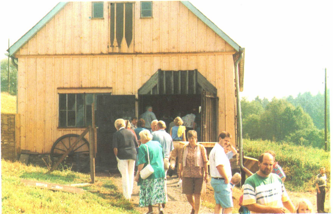
Zimmermannsarbeit exakt rekonstruiert. Die Außenhaut muß auch schon mal in alter Technik erneuert werden (Schmiede Anhalt).
