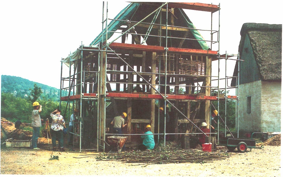
Noch sieht man nur das Gerüst des Fachwerkhäuses. Die Gefache werden aber bereits ausgeflochten und mit Lehm beworfen. Gefach für Gefach wird so geschlossen und zum Schluß mit einem Kalkanstrich geschützt; eine einfache aber höchst wirkungsvolle Bautechnik.
