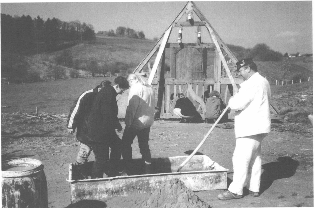
Auf die Mischung kommt es an: hautnah kamen die Schüler mit den Grundtechniken des Fachwerkbaus in Berührung.
