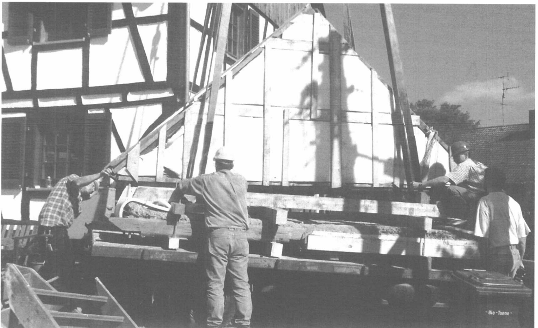
Zusammen mit den bereits demontierten Deckenteilen wird der Rauchfang mit dem Kran auf einen Tieflader für den Transport ins Museum verladen.
