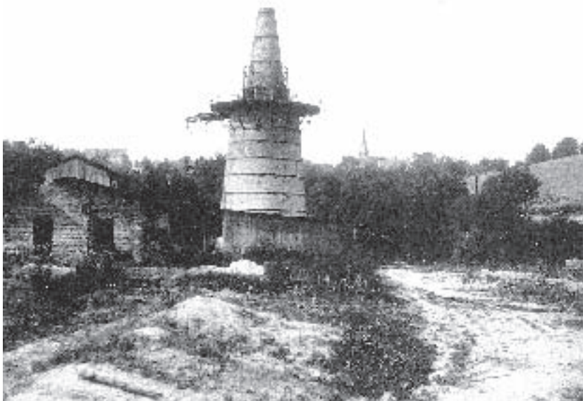
Der Schachtkalkofen in Linde (Foto: Renschler, Slg. Anne Scherer)
