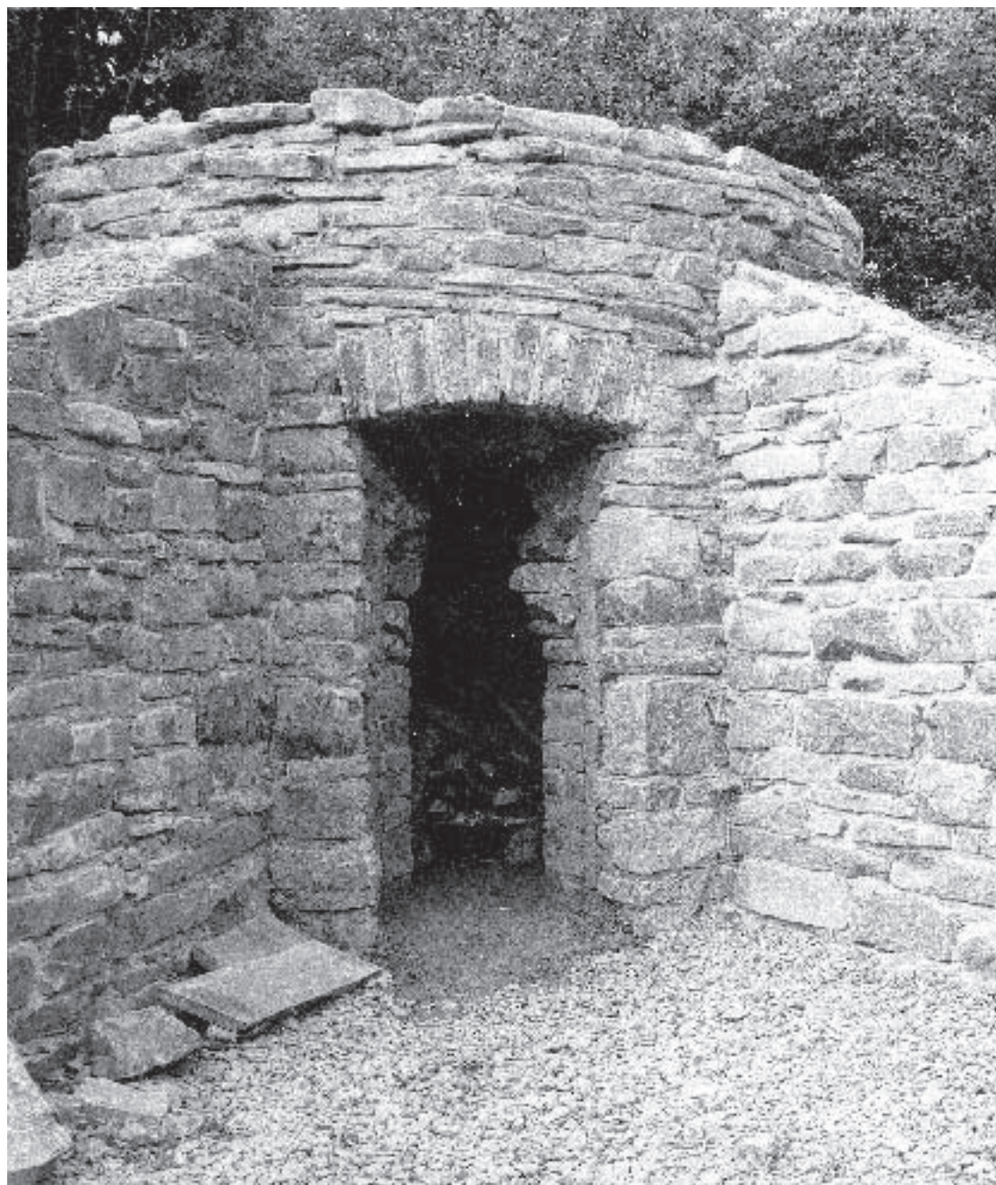
Der fertig gestellte Kalkofen - mit Blick auf die mit Holz gefüllte Brennkammer und das darüberliegende unverschaltete Gewölbe - im Museumsgelände
