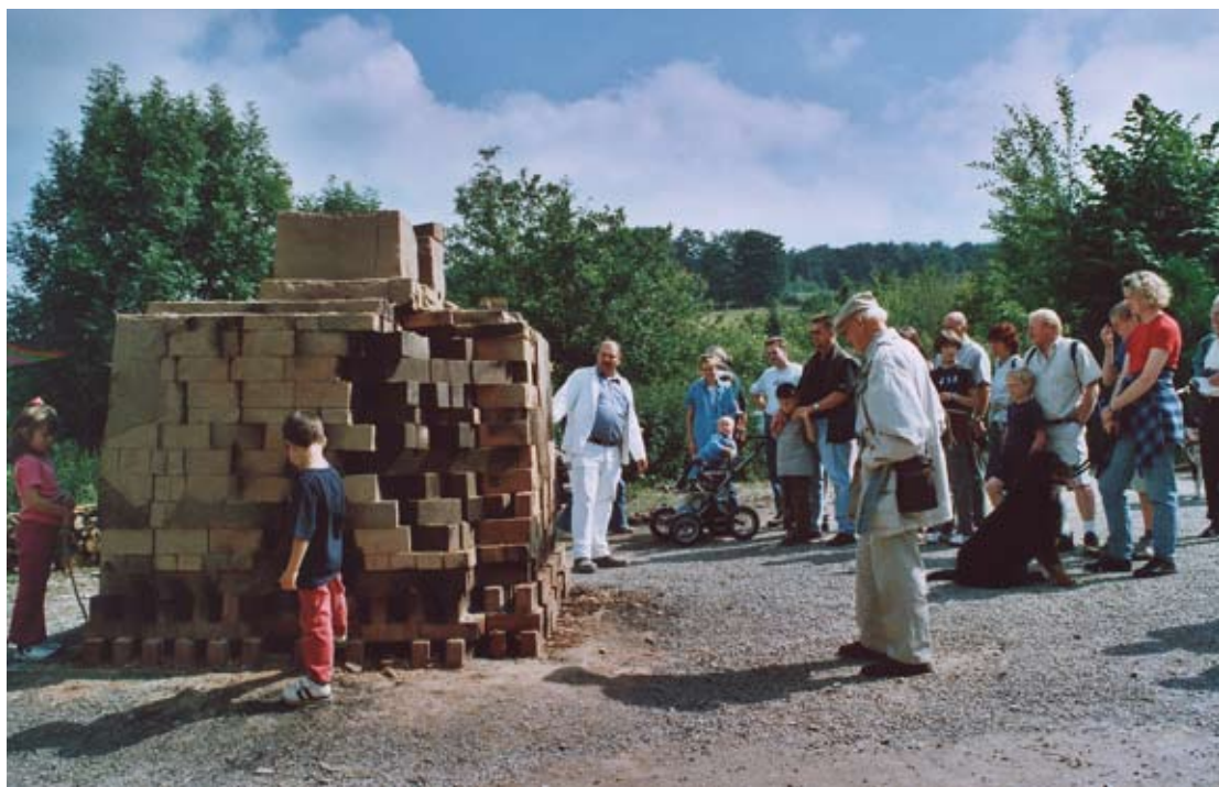
Der Brand ist gut gelungen und nach drei Tagen wurde der Feldbrandmeiler geöffnet. Nach Entfernen der Lehmschicht kann das Publikum die Aufsichtung und unterschiedlichen Qualitäten der gebrannten Steine sehr gut erkennen.
