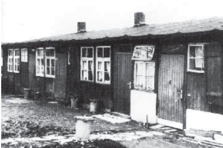
Aufnahmelager für viele, die erst einmal ein Dach über dem Kopf brauchten. Die Baracken in Lindlar – Falkenhof. Später war hier ein Altersheim untergebracht. (Foto aus: Nachbelichtet, Bergisch Gladbach, 1986, S. 101)
