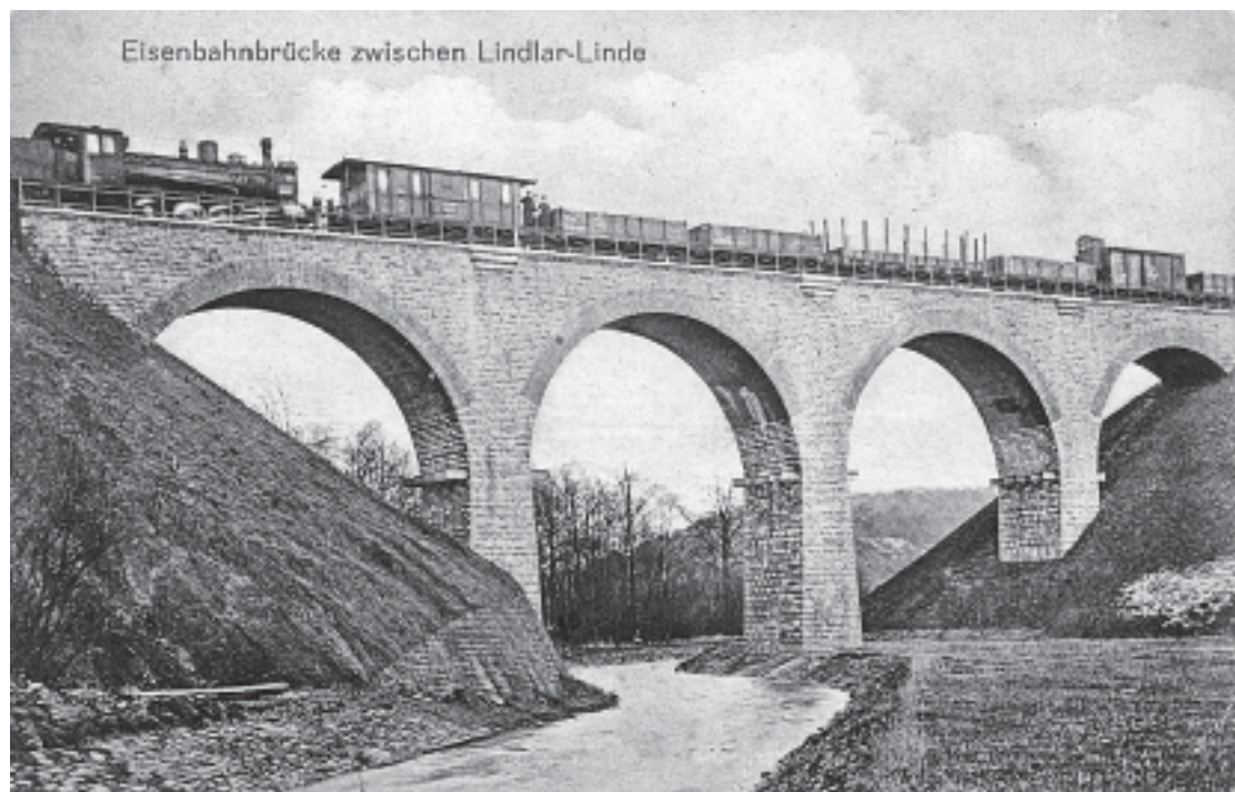
Viadukt bei Linde um 1913 - noch ohne Sülztalstraße
