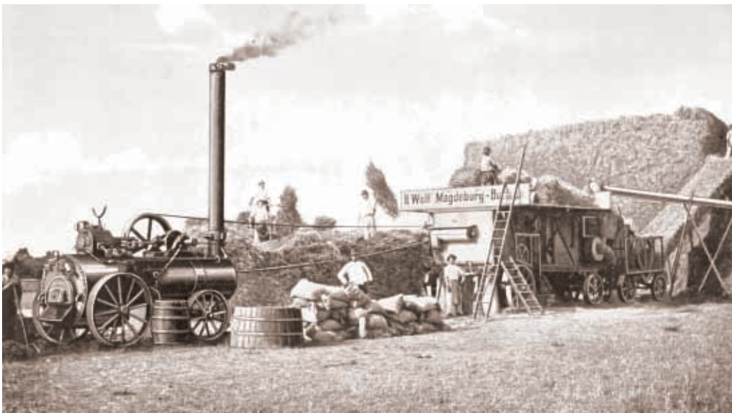
Dampfdreschsatz mit einer fahrbaren Heißdampflokobile beim Einsatz auf dem Feld um 1910. (Foto: Matschoss, Conrad: Die Maschinenfabrik R. Wolf, 1862-1912, Blatt 47)
