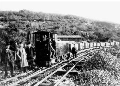
*Lorenzug auf der Überland-Feldbahn zwischen Müllenbach und Holzzipper mit einer Benzollokomotive von Deutz, um 1910
