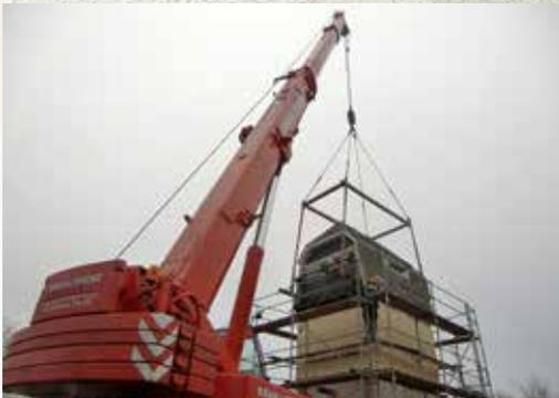
7. „Hochzeit“: Die drei Teile des Turmes wurden im Museum auf dem vorbereiteten, neuen Fundament wieder aufeinander gestellt. Anschließend wurden die Tragkonstruktionen entfernt und die verbleibenden Schnittstellen kraftschlüssig vermauert.
