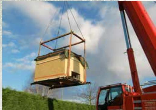
3. Nach erfolgter Verstrebung im Inneren des Turmes wurde der komplette Dachstuhl (ca. 5 Tonnen) am Stück abgehoben und auf einen Spezial-LKW verladen.
