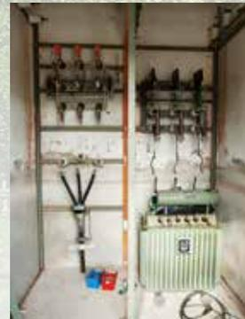
8. Abschließend folgte die Installation der Inneneinrichtung. Sie stammt aus einer Station in Wermelskirchen-Eibringhausen und zeigt den technischen Stand der 1930er- bis 1950er-Jahre.
