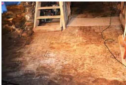
*Zwar mit einfachem Material, aber großem handwerklichem Geschick hergestellt: Fischgrätpflasterung der Diele mit Aufteilung in einzelne Kassetten*
